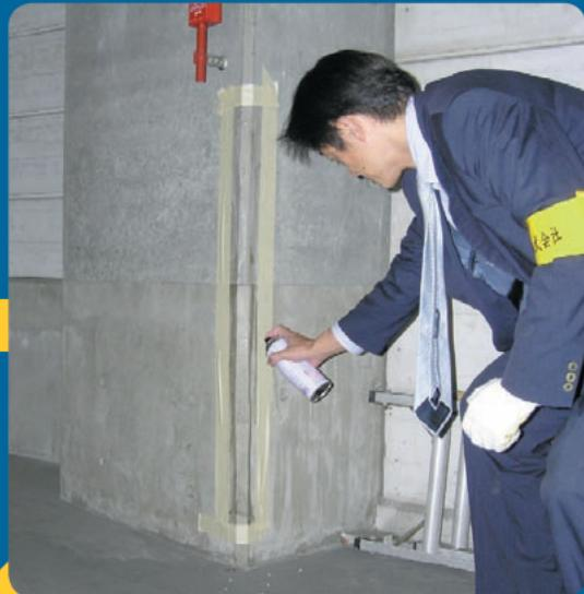
① 貼り付け位置を決めて、接着面の汚れ・ホコリ・セメントエフロ・レイダンス等を取り除きます。
