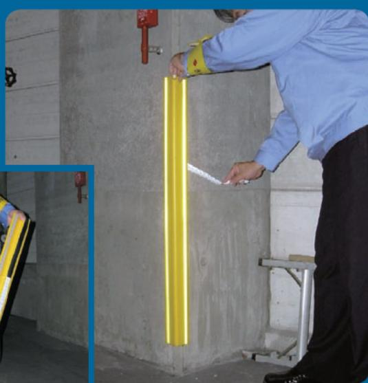
④ 裏紙をはがし取り付けます。はじめに片側の裏紙をはがし、片面を押し付けて支柱に取りつけた後、もう片側の裏紙をはがすときれいに施工できます。
