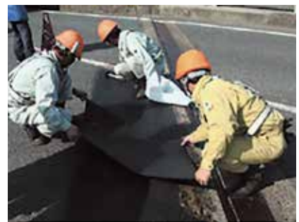
ジョイント部の補修箇所の保護
