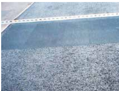
ジョイント部の段差修正
