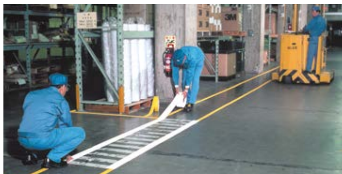
工場内施工例
