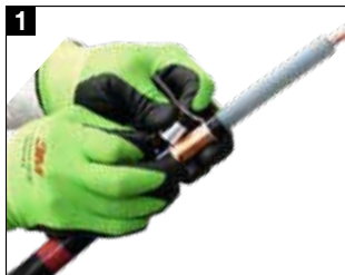
1 接地クランプの取付け。
