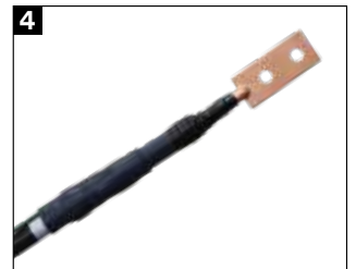
4 端子取付け後、充電部をテープで防水処理し、完成。
