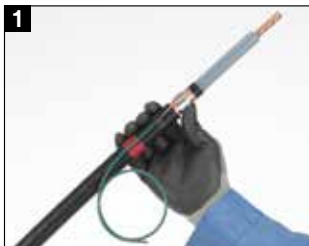
接地クランプの取付け。
