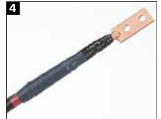
端子取付け後、充電部をテープで防水処理し、完成。
