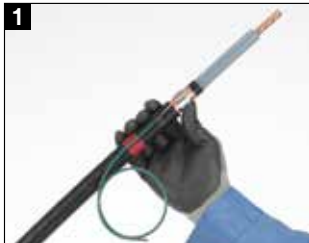
接地クランプの取付け。
