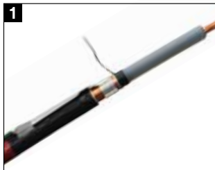
1 接地クランプの取付け。
