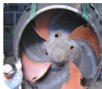
Восстановление крыльчатки насоса с помощью эпоксидного керамонаполненного материала 3M™ Scotchkote™ Epoxy Ceramic Rebuild EG 513 для ликвидации коррозионного повреждения с последующим покрытием 3M™ Scotchkote™ Epoxy Ceramic Surfacer FG 512 для получения гладкого финишного покрытия.
