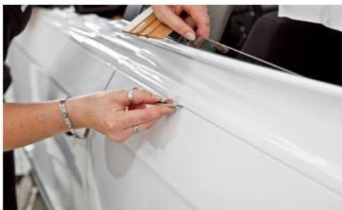
Tagliare la pellicola almeno 2 mm sopra la guarnizione. Al termine spatolare la pellicola sotto la guarnizione. Per questa operazione si raccomanda di utilizzare il nastro 3M Knifeless.
