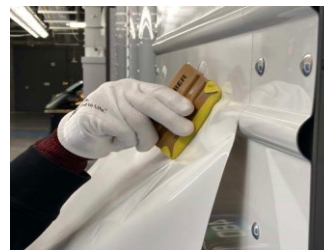
Figura 3. Spatolare la parte superiore della corrugazione.
