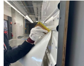
Figura 5. Sagomare la scanalatura inferiore.
