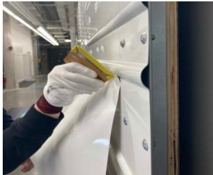
Figura 4. Spatolare la parte inferiore della corrugazione.
