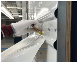
Figura 2. Sagomare la scanalatura superiore.
