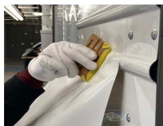
Figura 3. Pase la espátula por la corona de la corrugación.
