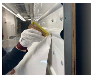
Figura 4. Pase la espátula por la parte inferior de la corrugación.
