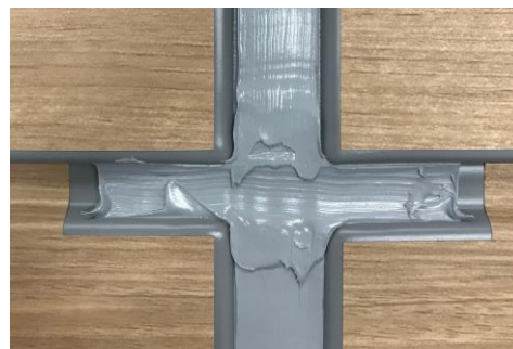
図 2.4.7.2 タッチアップ塗装の納め方例 (左：模式図、右：参考写真)
