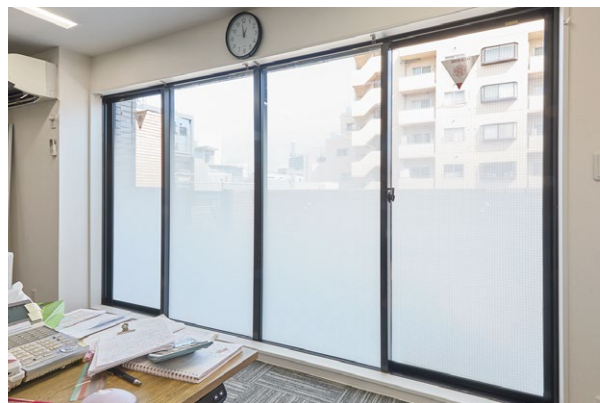
フィルム施工後
