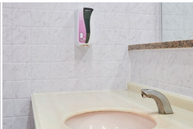
東武東上線 朝霞台駅 壁面/ST-024TIL
