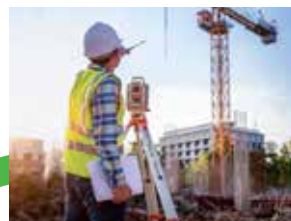
Manufatura industrial - construção
