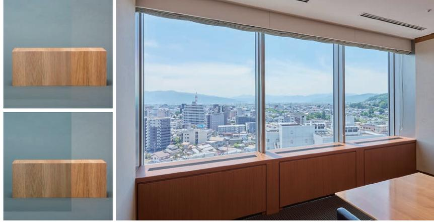
窓ガラスに貼るフィルムの種類を変えて窓際の温度測定を実施した。NANO70S 貼付時とフィルムなしの窓際の温度差は、平均3.2°C、最大4.5°C。ガラスはLow-E複層ガラス。
