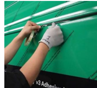
Figure 25. Applying Edge Tape
