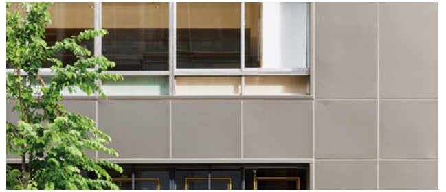
太陽ビル (3M™ ダイノック™ フィルム EXシリーズの先行品を施工)
