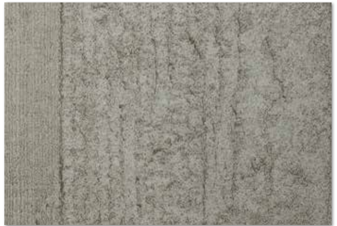
CN-2512 コンクリート(杉板型枠) NEW
