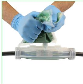
Platzieren Sie den Einfüllstutzen auf der Vergusschale und führen Sie eine Vierteldrehung aus, um das Harz auszugießen und die Garnitur zu befüllen.
