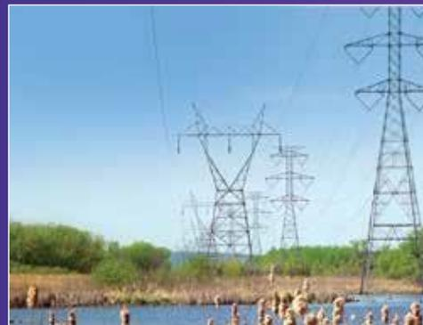
3M™ ACCR (Aluminum Conductor, Composite Reinforced) é um tipo avançado de cabo de transmissão de energia que emprega uma exclusiva tecnologia 3M com compósito de matriz metálica para aumentar significativamente a ampacidade, comparada com cabo de aço convencional. Com menos subsidência sob carga de calor, o ACCR também provou ser especialmente eficaz para uso em aplicações de longas extensões, como em interseções de rios.
