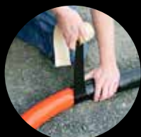
Réparation des dommages plus importants sur la gaine de câble
