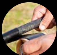
Réparation des rayures mineures sur les gaines de câbles
