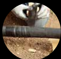
Réparation temporaire de coupures mineures dans les gaines de câbles
