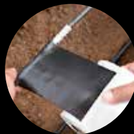
Étanchéité à l'humidité pour les connexions de raccordement externes
