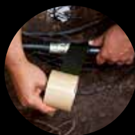
Raccordement et scellement à l'extérieur
