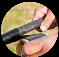
Reparaturen geringfügiger Beschädigungen an Kabelmänteln
