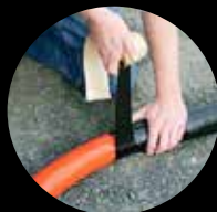
Reparatur von erheblichen Beschädigungen an Kabelmänteln
