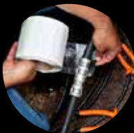
Spleißen in feuchten Bereichen
