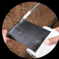
Sellado de humedad para conexiones de empalme externo
