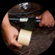
Empalmes y sellado en áreas exteriores
