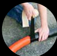
Reparación de daños importantes en cubiertas de cables
