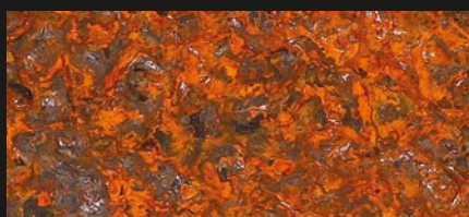
Zonder behandeling voor corrosiebescherming
