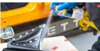
► Applicare il protettivo a base zinco 3M™ su tutte le aree del pannello di alloggiamento e del pannello di sostituzione che richiedono operazioni di saldatura, eccetto le aree per l'incollaggio
