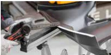
► Retirez le revêtement électrophorèse des zones de la bride de jonctions du panneau de remplacement à l'aide d'une bande Scotch-Brite™
