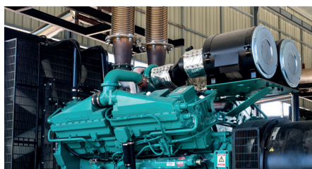
Prace konserwacyjne i naprawcze na górze maszyny
