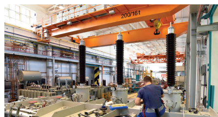
Lavoro di assemblaggio della linea di produzione sotto una gru
