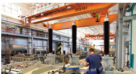
Travaux d'assemblage de la chaîne de production sous une grue
