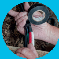
Draad en kabels bundelen
