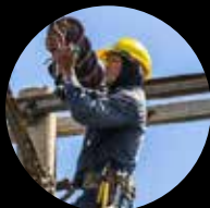
Fuktiga och korroderande miljöer
