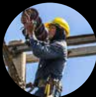
Ambienti umidi e corrosivi
