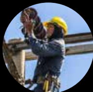
Environnements humides et corrosifs
