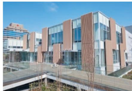
約10年の屋外耐候性と耐汚染性能を兼ね備えたフィルム。ビルの外装、ルーバー、扉やサッシなど屋外の幅広い用途で活躍します。
