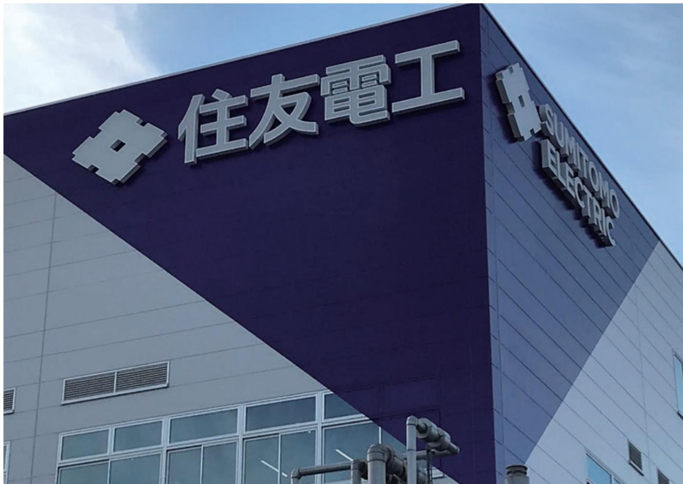
耐候性が塗装同等以上のフィルムを短工期で高所作業車で迅速に施工可能であるため短工期（足場設置不要、養生不要）であること、ならびに本案件で比較された塗装と同等以上の耐候性を見込み、採用。
