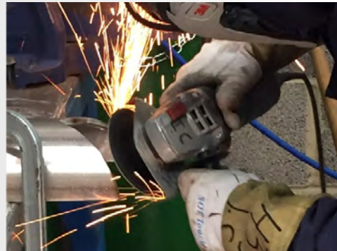
Préparation de la soudure – 3M™ 987C/787C 60+ disque fibre
