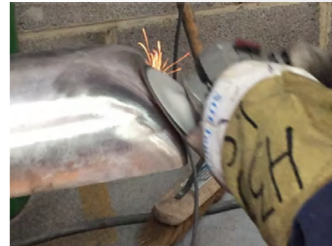
Soudure enlevée, surface entièrement affinée
