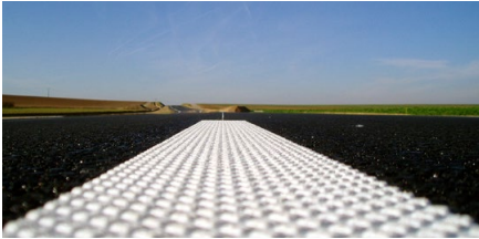
Die profilierte Folienmarkierung A380 ESD von 3M hat ein einzigartiges Waffelmuster, in das abriebfeste, retroreflektierende Keramikperlen eingearbeitet wurden.
