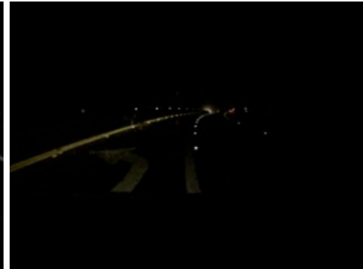
Warunki nocne podczas deszczu W deszczu, gdy oznakowanie krawędziowe wykonane z materiałów odblaskowych w warunkach zamoczenia pozostaje wciąż świetnie widoczne, symbol i linia segregacyjna, wykonane z materiałów nieodblaskowych w stanie zamoczenia, przestają być widoczne dla kierowcy.
