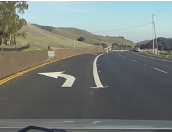
W ciągu dnia w warunkach suchych Zarówno odblaskowy symbol na nawierzchni, linia segregacyjna, jak i żółta linia krawędziowa są widoczne.
