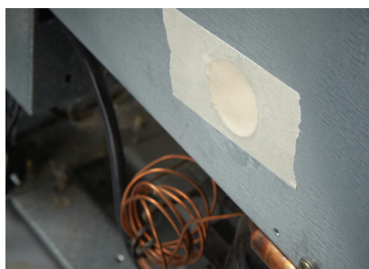
Uszczelnianie przy pianowaniu
