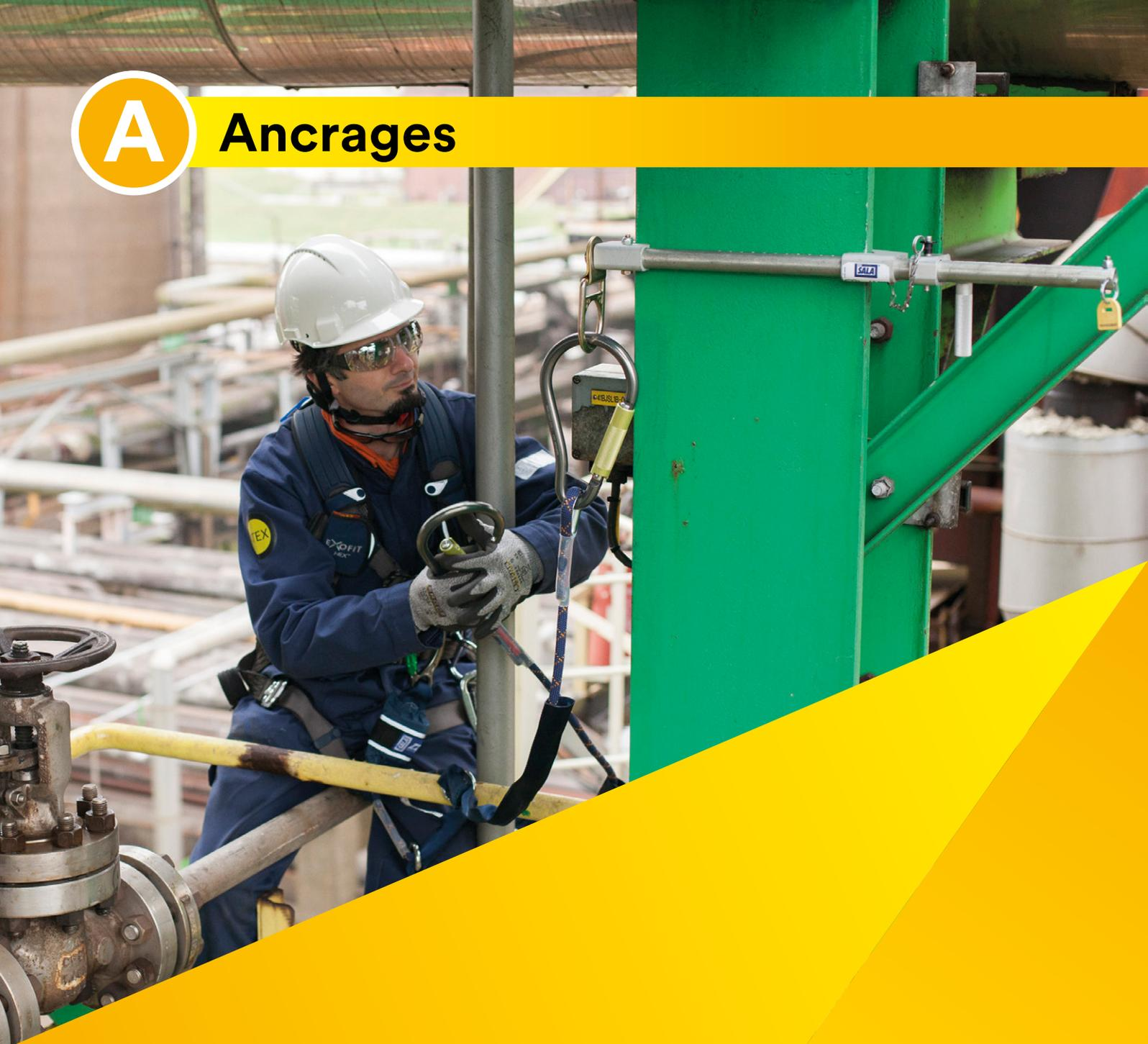
**Les ancrages représentent un point de fixation sûr. Les connecteurs d'ancrage varient en fonction du secteur, du travail réalisé, du type d'installation et de la structure. Ils doivent être en mesure de tenir solidement sous le poids d'une chute, lors de travaux en suspension ou lors d'un sauvetage.**
