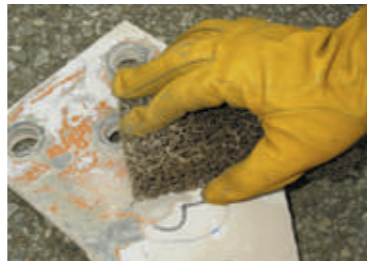
古い塗膜剥離
