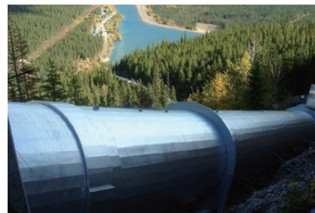
■ 야외 노출 배관 시공
