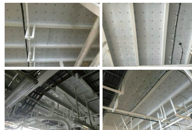
■ 선체 보온 마감 시공
