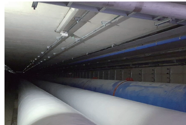
■ 지하 공동구 배관 시공 (내화학적성)
