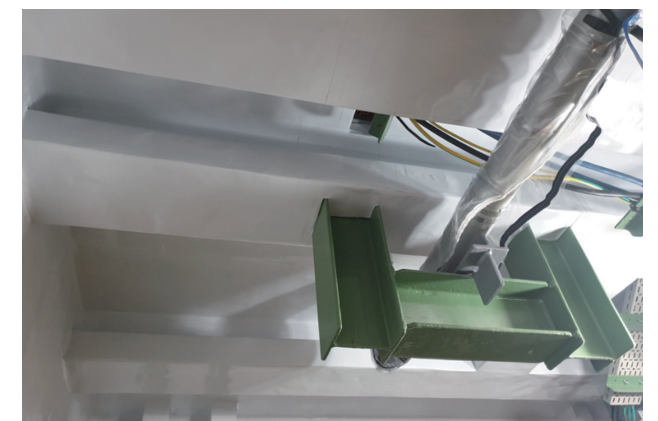
■ 선체 보온 마감 시공
