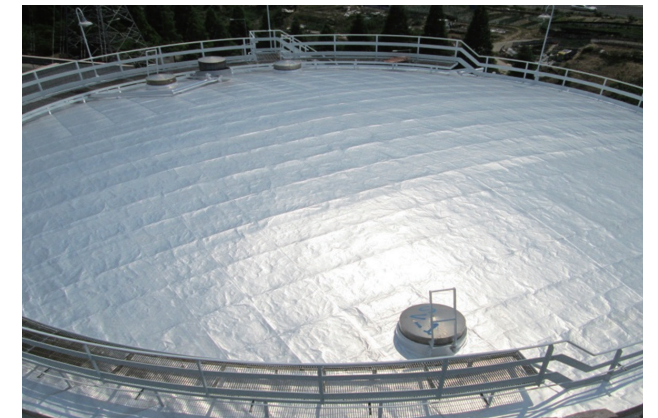
■ 축열조 루프탑 시공
