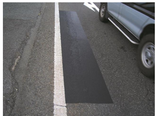
「3M™ ステイマーク™ 路面補修材 L715」(表面拡大)と本製品を使って路面に施工した様子
