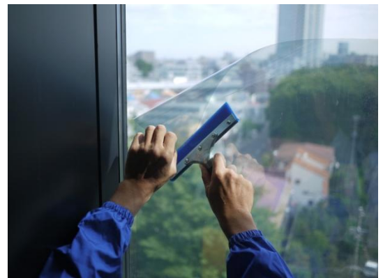
3M™ スコッチテント™ ウインドウフィルムを窓ガラスに貼付するイメージ
