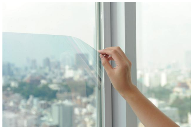
窓ガラスに貼り付けする様子
