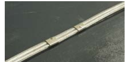
漏水システム復帰完了！
