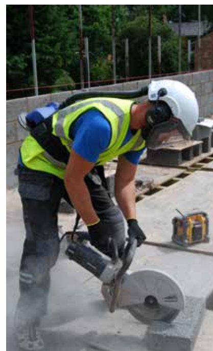
Figure 2 – Activités de construction susceptibles de créer de la silice cristalline
