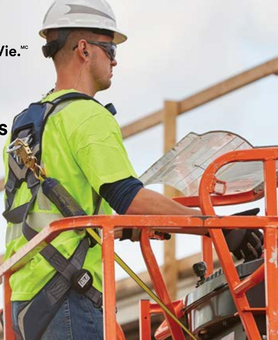
Les plates-formes de travail élévatrices mobiles (PTEM), également appelées les plates-formes de travail aériennes, plates-formes élévatrices à ciseaux, nacelle aérienne, etc., sont des appareils industriels utiles pour positionner les travailleurs, les outils et les matériaux. Leur utilisation répandue et leur popularité sont évidentes dans de nombreux secteurs.
