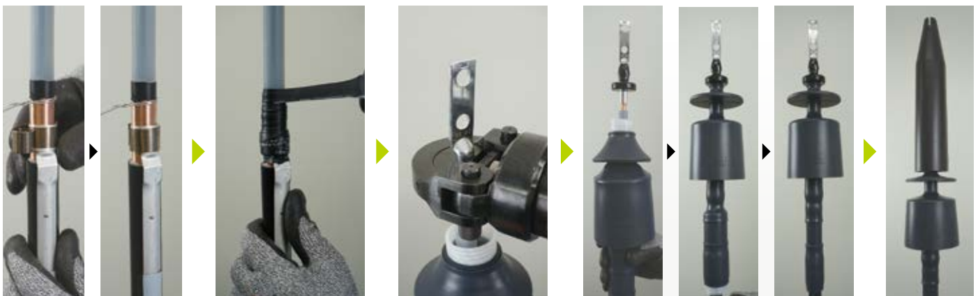
1. 接地用クランプの取付け
